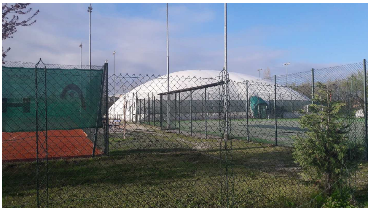
RIPRESA FOTOGRAFICA 1: Area oggetto di intervento, prospetto est. Attualmente lo spazio sportivo è adibito all'attività sportiva calcio e presenta un manto in erba sintetica.
