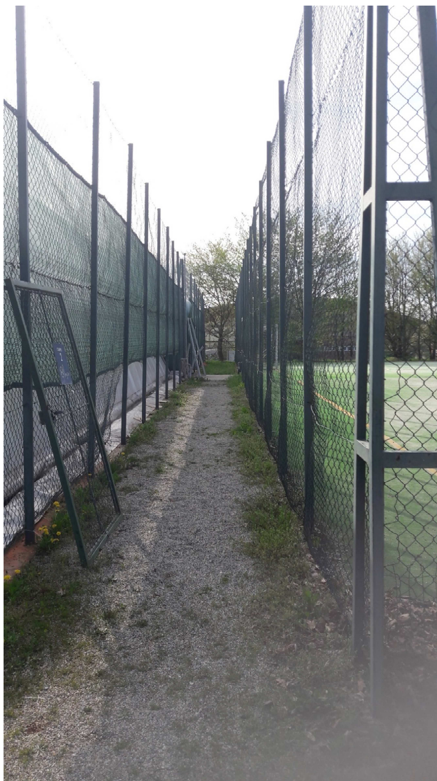
RIPRESA FOTOGRAFICA 4: Area oggetto di intervento, prospetto sud. A sinistra è osservabile il limite, recintato, dei campi da tennis attualmente coperti da pallone pressostatico; a destra il limite dei campetti da calcetto oggetto della trasformazione in oggetto a campi da tennis coperti. L'area strumentale all'attività sportiva tennis è separata dai campetti di calcio da un percorso pedonale.
